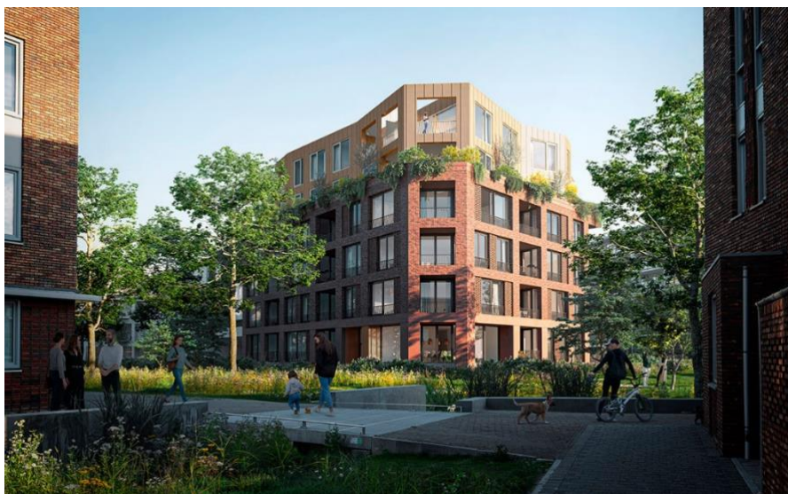
Een groot deel van de woningbouwprogrammering bestaat uit appartementen – De Silo, Havencentrum, Apeldoorn (bron: studiokomma.nl)
