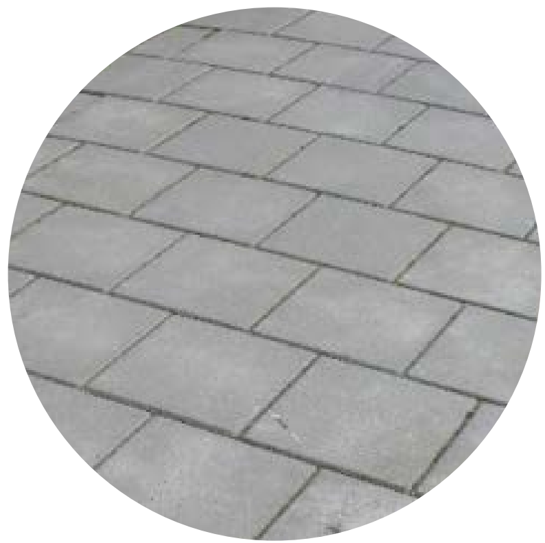
Voetpad Betontegels 30x30 grijs met facet Halfsteensverband
