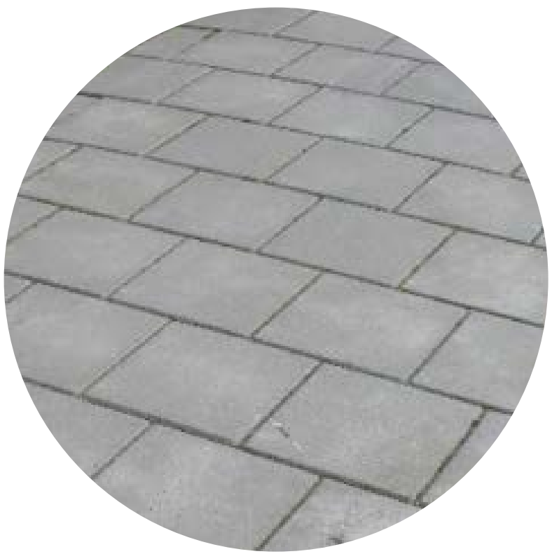
Voetpad Betontegels 30x30 grijs met facet Halfsteensverband
