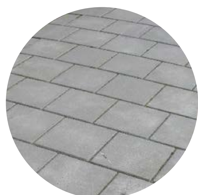
Voetpad Betontegels 30x30 grijs met facet Halfsteensverband
