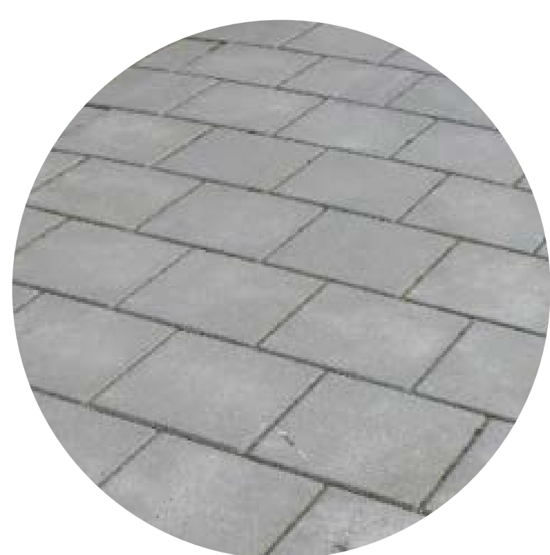
Voetpad Betontegels 30x30 grijs met facet Halfsteensverband
