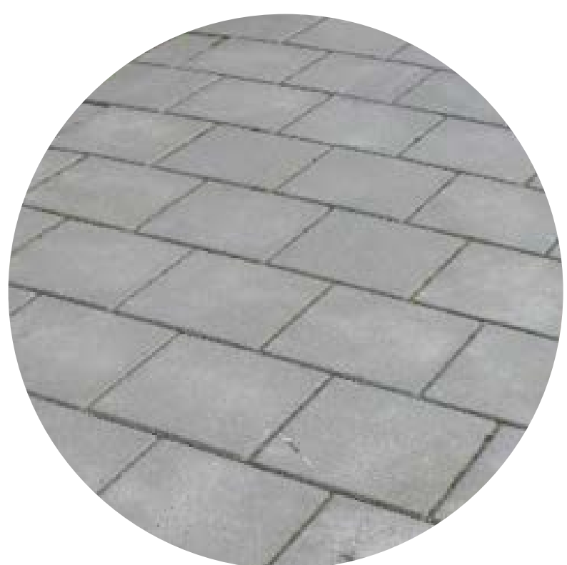
Voetpad Betontegels 30x30 grijs met facet Halfsteensverband
