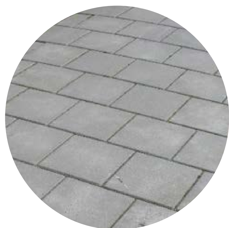
Voetpad Betontegels 30x30 grijs met facet Halfsteensverband
