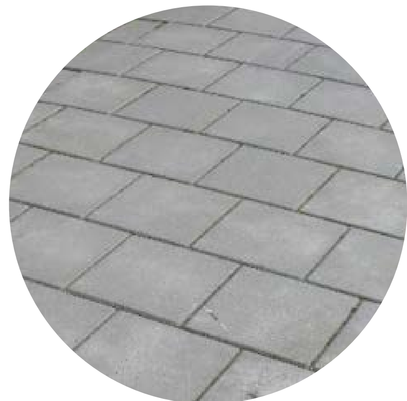
Voetpad Betontegels 30x30 grijs met facet Halfsteensverband
